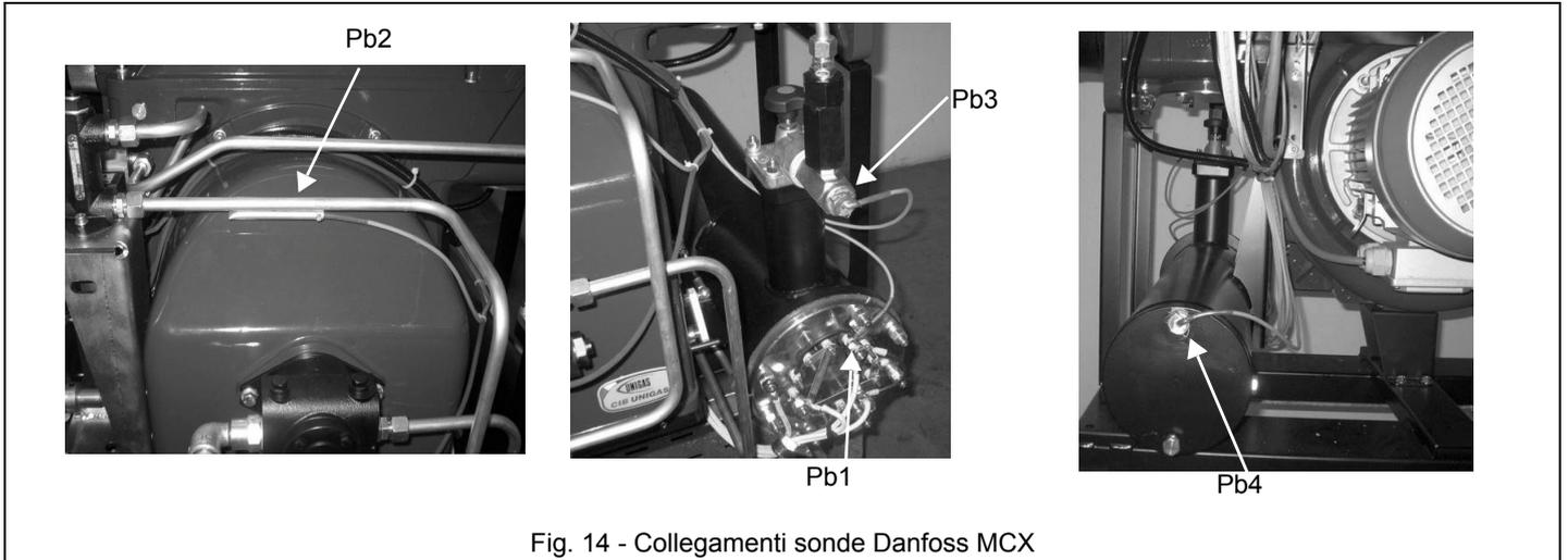
Fig. 14 - Collegamenti sonde Danfoss MCX
